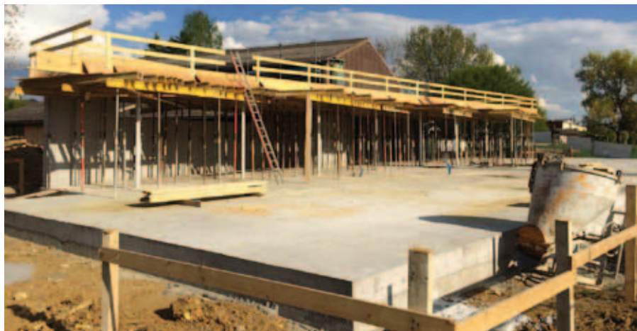
Neubau Doppelkindergarten mit Aula und Sanierung Turnhalle – S. 2
